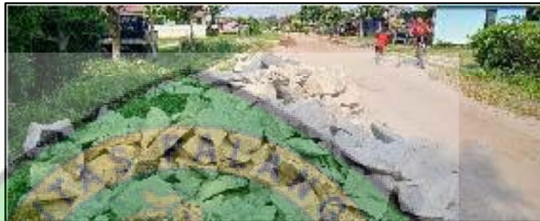
Gambar 4.6 Stasiun 2 Jalan Bakung Merang
