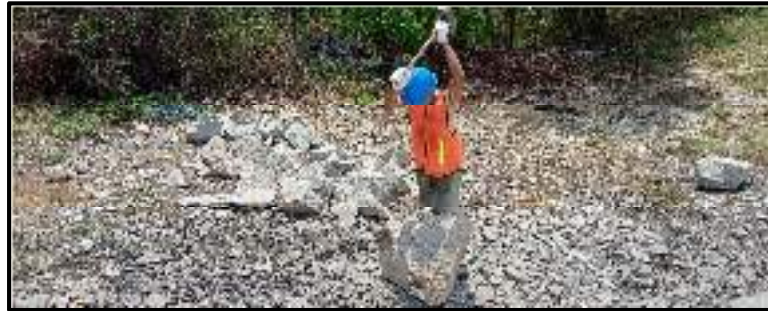
Gambar 4.3 Pemecahan Bongkahan Batu Granit
